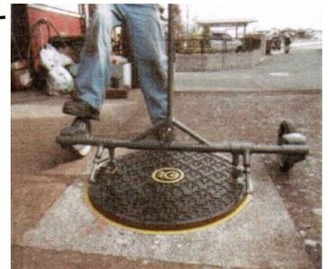
◎本体を反転して回転してロックを外す(NSS型)
